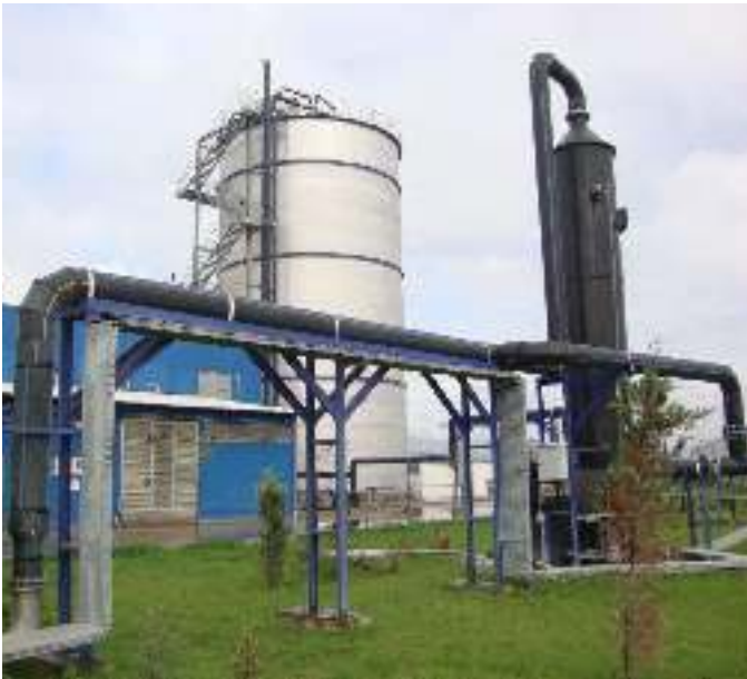
WET SCRUBBER GENEL GÖRÜNTÜ
